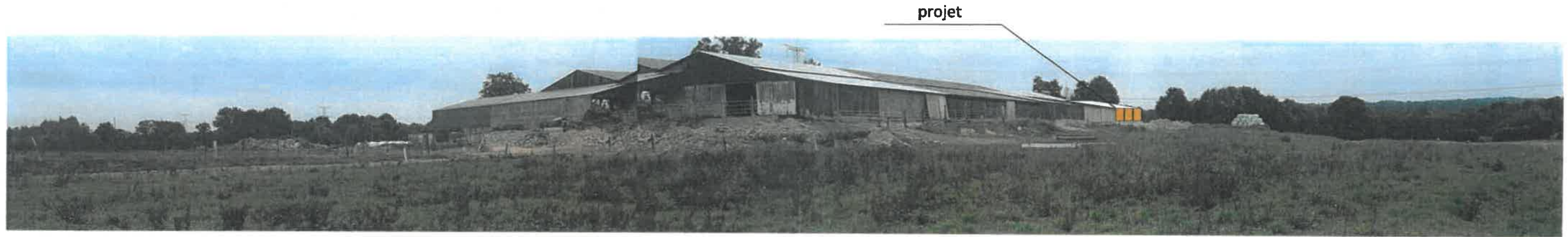
Vue sud des bâtiments existant
